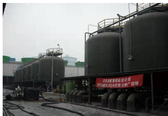
图 2 原位再生工艺技术场景
